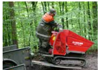
Vorbereitung am Schadenplatz II
